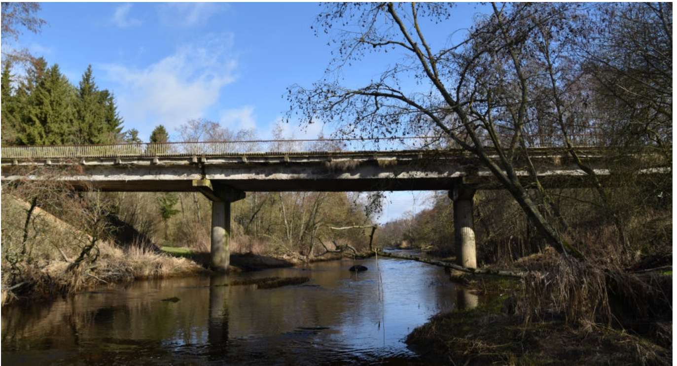
2 pav. Tilto per Šušvės upę fasadinis vaizdas
