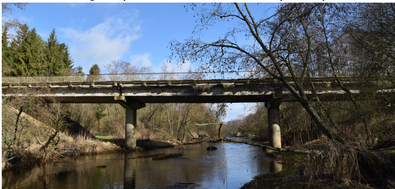
2 pav. Tiltu per Šušvės upę fasadinis vaizdas
